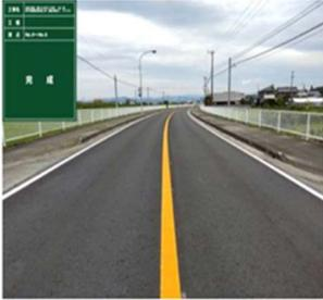
施工延長 336.5m、表層 2360m<sup>2</sup>、基層 2360m<sup>2</sup>、上層路盤 2360m<sup>2</sup>、区画線設置(溶融式手動)実線15cm 670m、高視認性区画線設置 340m
