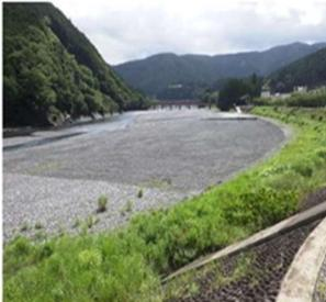
河床掘削工 掘削(CT)(CT建機使用割合100%)16800m<sup>3</sup> 土砂等運搬16800m<sup>3</sup>
